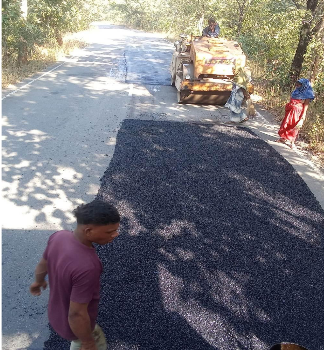
जिला कोरबा के पसान-पिपरिया-दुल्लापुर मार्ग में पेच रिपेयर कार्य
